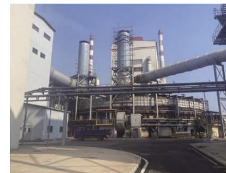
J 科技有限公司是一家专业从事余热余能发电、脱硫脱硝、除尘、污水处理的公司。2023 年初，J 公司向公司融资 2.83 亿元用于其工业废气脱硫脱硝项目，该项目 2 号、3 号烧结机机头烟气各自经一套“双室四电场静电除尘器（利旧）+CFB 循环流化床半干法脱硝 + 覆膜袋式除尘器 +GGH+SCR 中温脱硝反应器”设施处理后再外排，确保废气排放严格执行《钢铁工业大气污染物超低排放标准》（DB13/2169-2018）相关要求。
